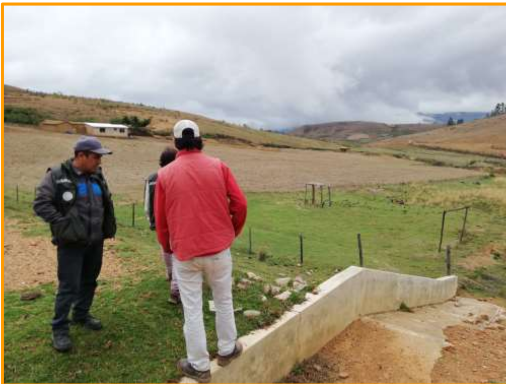
Imagen 5: vista de una de las obras de aprovechamiento de agua
